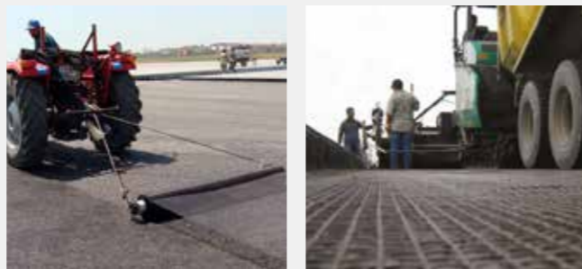
Ugradnja ADFORS GlasGrid mreže na Aerodromu Atatürk, 2010
