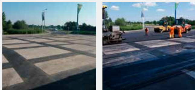
Ugradnja ADFORS GlasGrid mreže na putu Beograd-Niš, 2018
