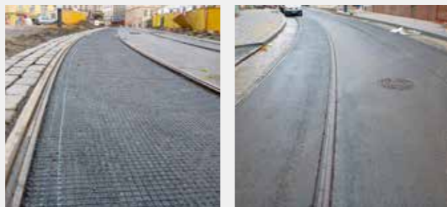
Ugradnja ADFORS GlasGrid mreže u Pragu, 2013
